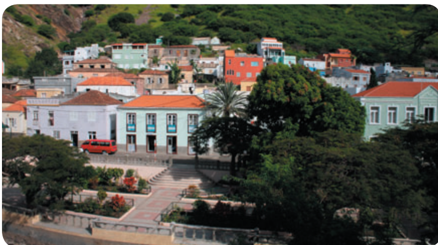
Plano de actividades de 2011 aposta forte na água, energia e meio ambiente
