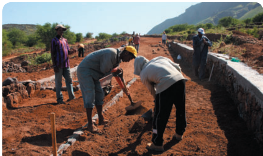
Decorrem a bom ritmo as obras da estrada Juncalinho - Carriçal
