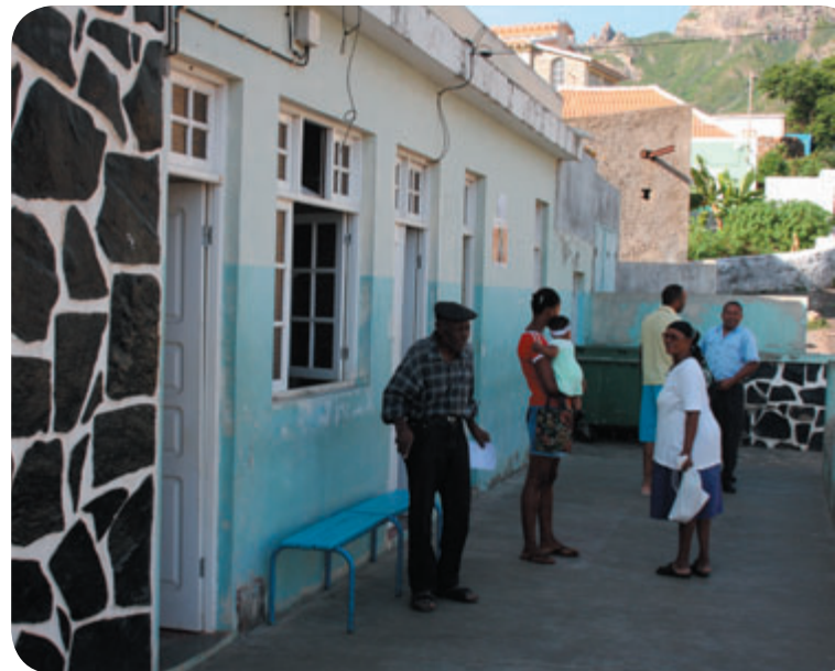
Centro de Saúde de Fajã vai entrar em obras
