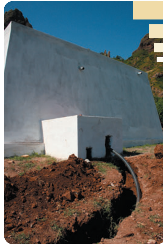
Reservatório de água das Patas vai abastecer todo o Vale da Ribeira Brava
