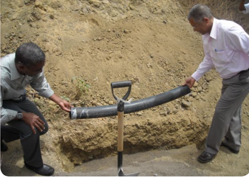
Colocação do 1º Tubo de Adução de Água a Chã de Norte
