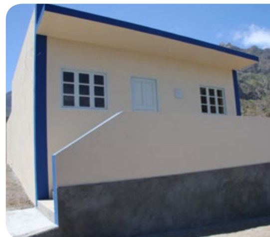
Construção foi realizada em parceria com a CVT
