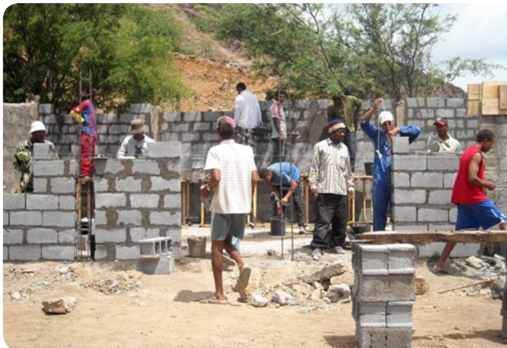
Os novos pedreiros trabalharão na reconstrução do município
