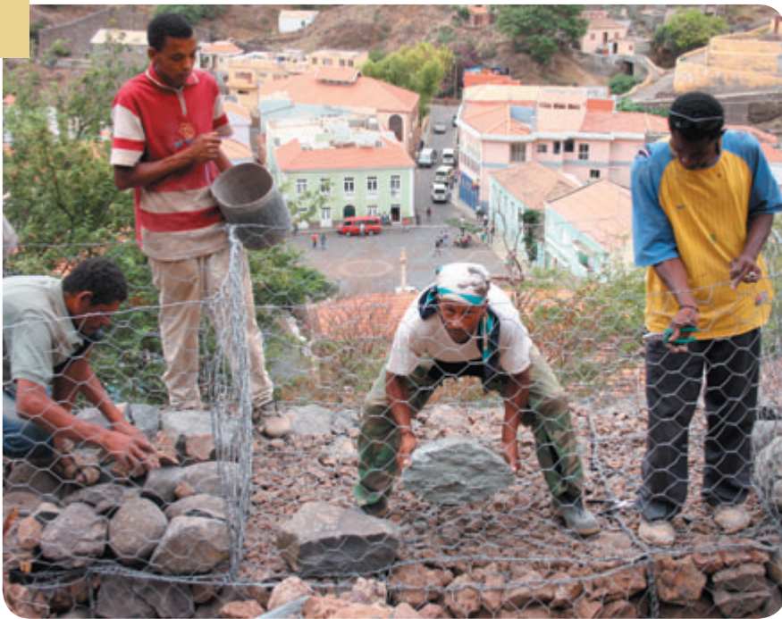
Cerca de 100 trabalhadores estão ajudar na protecção da encosta da Vila
