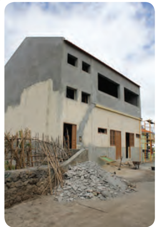
As obras do Centro Multiusos do Cachaço também decorrem a bom ritmo. Em breve os jovens desta localidade vão ter um espaço de lazer e acesso ao conhecimento.
