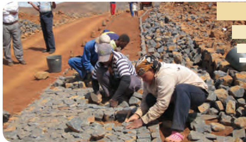
Autarquia deu formação em calçetaria para as obras da Câmara
