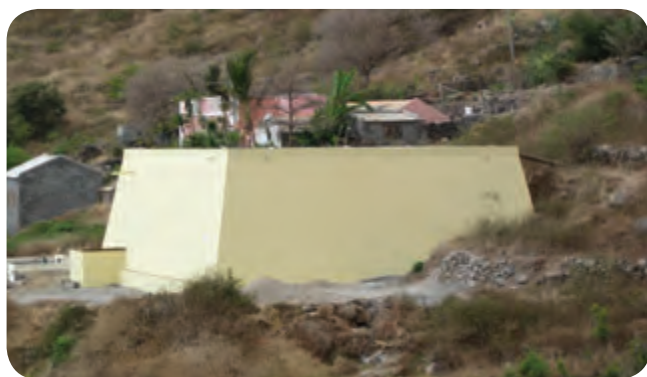
Reservatório do Caleijão
