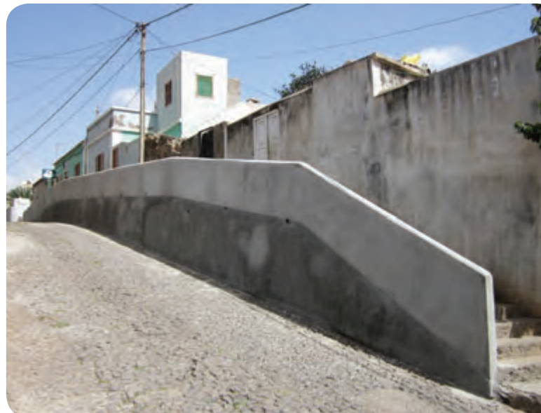
Construção da protecção de um passeio elevado na Cidade da Ribeira Brava
